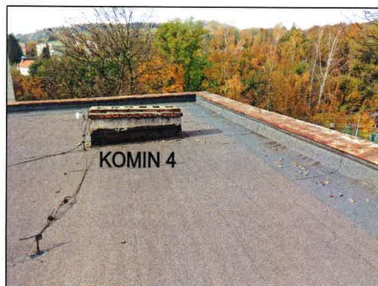
do przemurowania cegła klinkierowa pełna wloty na boki
