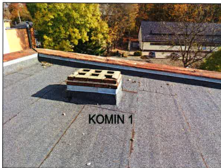
do przemurowania cegła klinkierowa pełna wloty na boki
