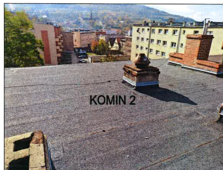
do przemurowania cegła klinkierowa pełna
